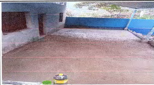
Foto 2: PISO DEL CORREDOR DE LA COCINA INSTALADA
