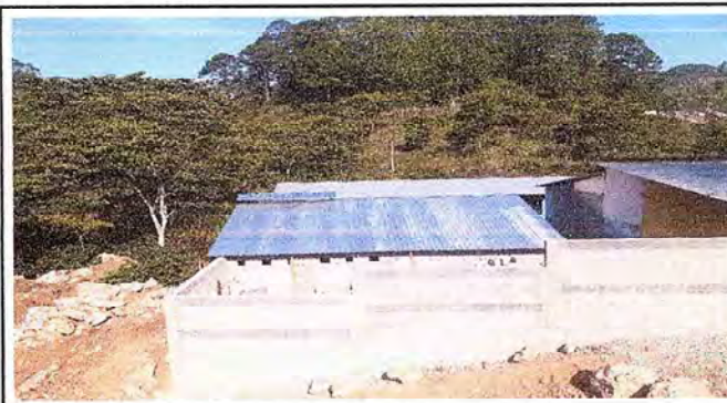
Foto 4: TECHO DE LA COCINA INSTALADA
