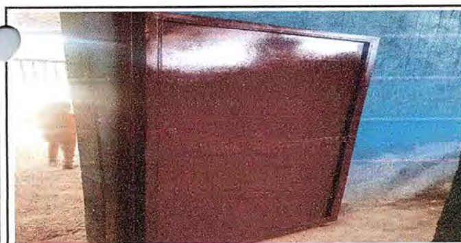
Foto 5: INSTALACION DE LA PUERTA UNA DE LAS AULAS
