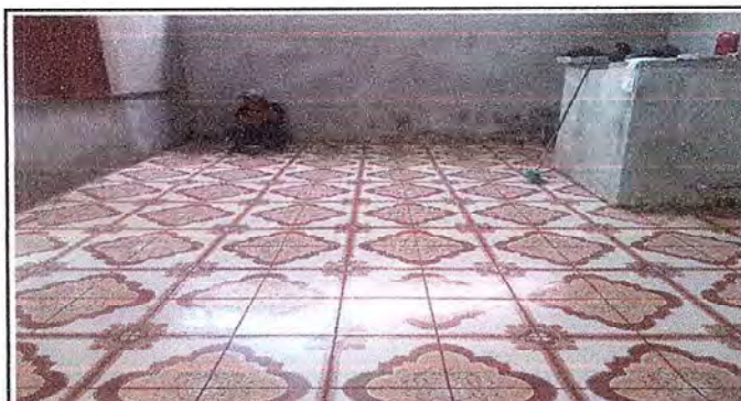
Foto 3: PISO INSTALADA DE LA COCINA
